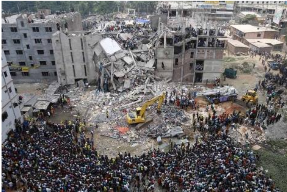
FIGURA 21. Derrumbe de un edificio en Bangladesh que albergaba talleres textiles.
