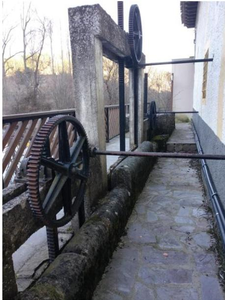
Imagen 6. Mecanismo que abría y cerraba las compuertas para el agua del molino.
